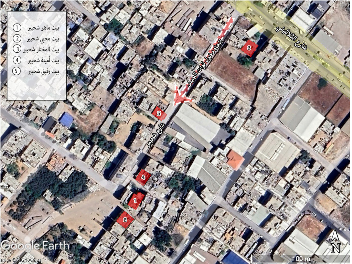
موقع شارع شحيبر في منطقة الصبرة بمدينة غزة، واتجاه دخول قوات جيش الاحتلال الإسرائيلي الشارع. ومواقع المباني السكنية التي تم استهدافها قبل دخول قوات الجيش. صورة: © 2024 إيرباص، جوجل إيرث.
